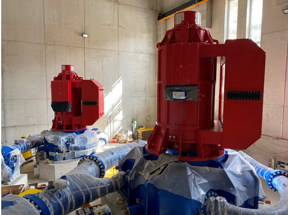
Montage der Maschinengruppen in der Kraftwerkzentrale Gere
