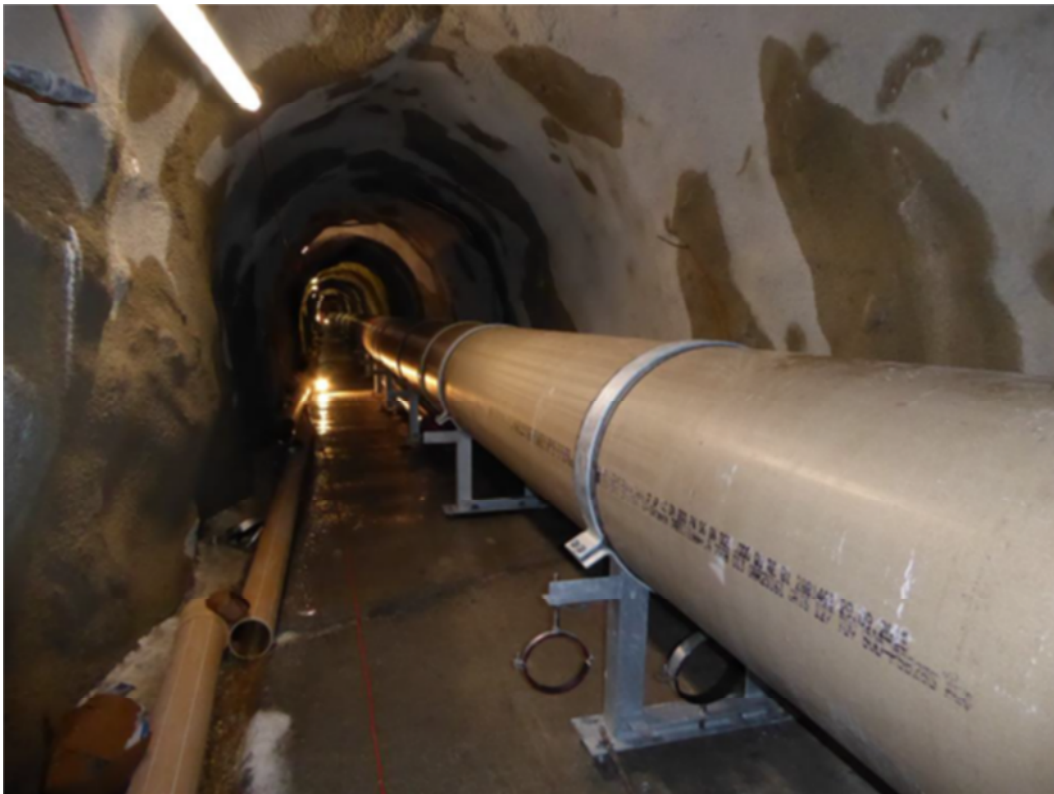
Beispiel des zukünftigen Stollens mit Druckleitung
